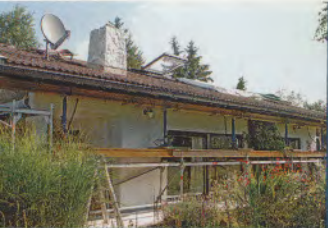
Der erste Schritt: Auf dem Gerüst rund ums Haus ...
