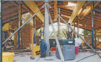
Gut abgestützt und gesichert präsentiert sich das Dach auch von innen.
