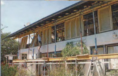
Die richtige Höhe ist erreicht. Die neuen Wände werden in Holzständerbauweise montiert.
