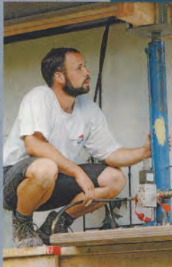
Präzise: Mit Augenmaß begutachteten die Fachleute den Sitz der Hydraulik-Stützen.
