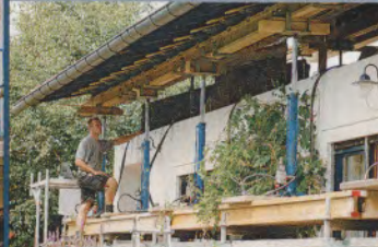
Ready for Take off: Das Dach hebt langsam ab und schwebt über den Mauern des Erdgeschosses.
